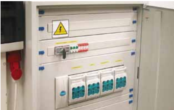
Fotografia 3. Ochronniki zabezpieczające urządzenia przed przepięciami indukowanymi.
