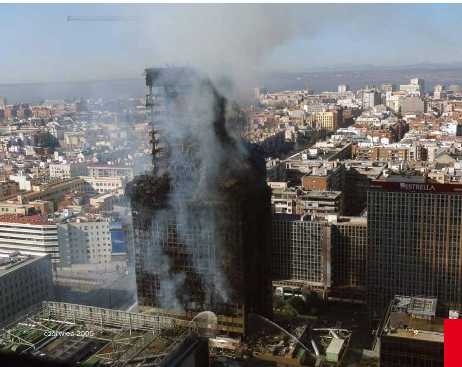
Wieżowiec Windsor w Madrycie po pożarze (źródło: PAP/EPA)
