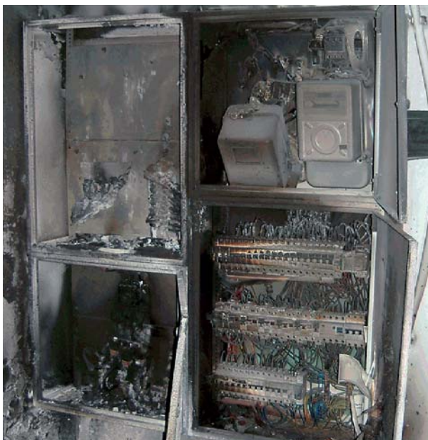
Fotografia 1. Zniszczona rozdzielnica.
